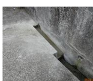
地藏堂北の小排水路
