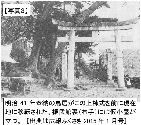
【写真3】明治41年奉納の鳥居がこの上棟式を前に現在地に移転された。振武館裏(右手)には仮小屋が立つ。【出典は広報ふくさき 2015年1月号】
