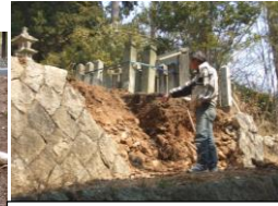
↑3/16 盤膨れの石垣修復
