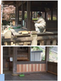
4/12 鈴の森神社拝殿の腰板と賽銭箱の修理
