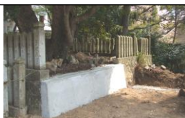
4/12 山桃の根元を擁壁で補強
