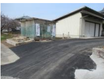
2/3 舗装工事完了
