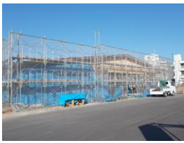
建設中の辻川観光交流センター
