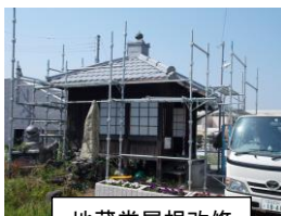
地藏堂屋根改修
