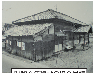
昭和3年建設の旧公民館 (昭和50年頃撮影)
